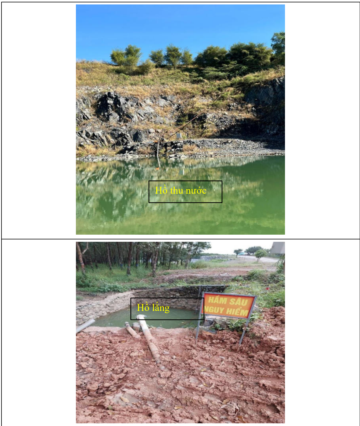
Hình 3.3. Hiện trạng các công trình thu gom, thoát nước thải là nước tháo khô mỏ
