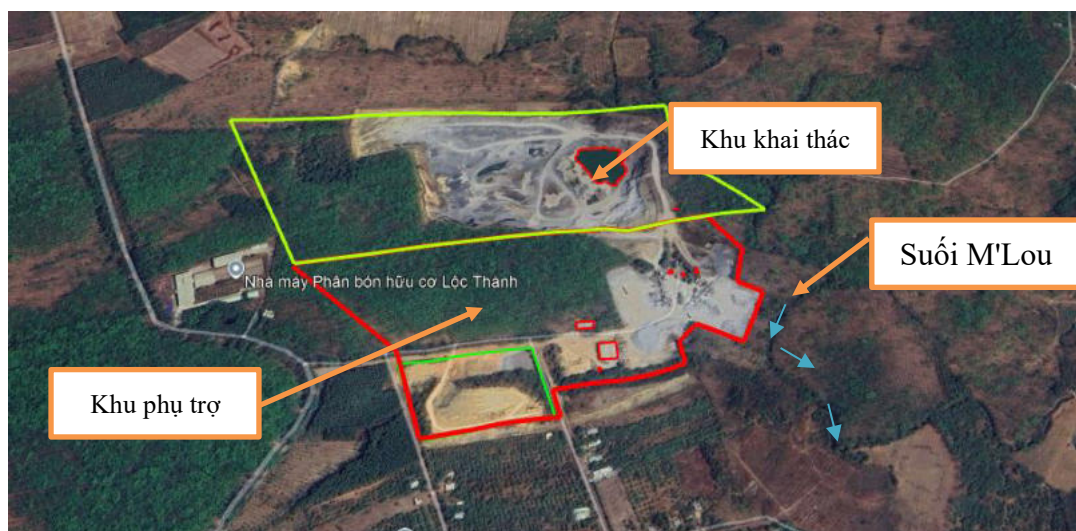
Hình 2.1. Mô tả nguồn tiếp nhận nước tháo khô của dự án
