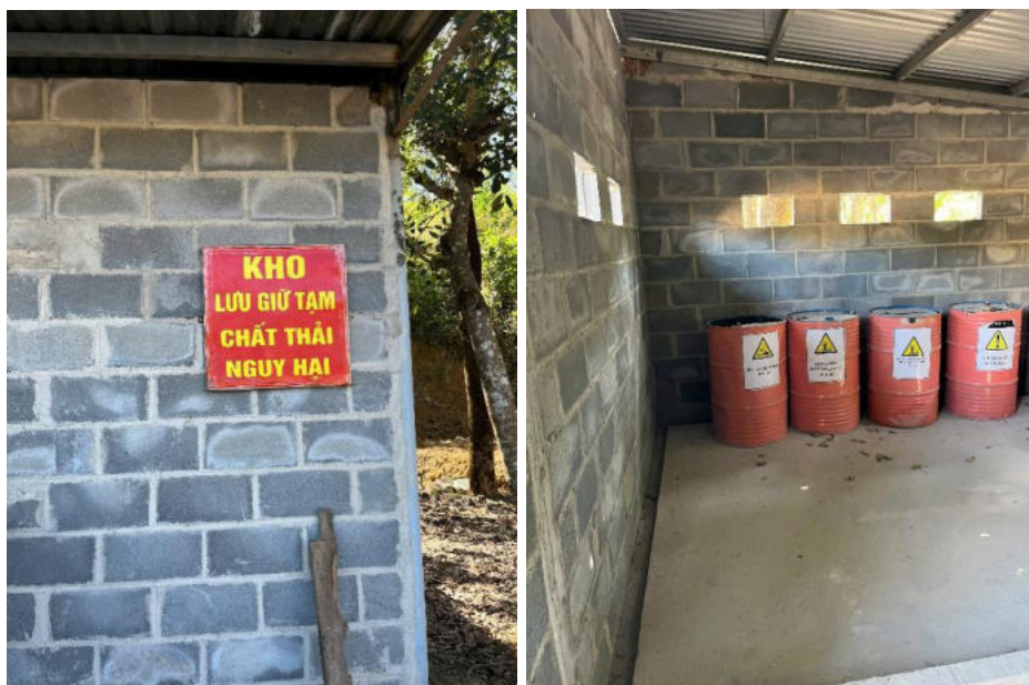
Hình 3.5. Hình ảnh hiện trạng Kho chứa tạm CTNH
