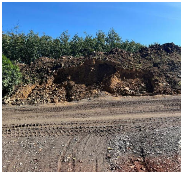
Hiện trạng đê bao kết hợp làm đường vận chuyển
